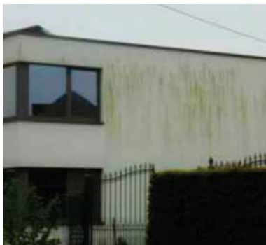
Afb. 33 en 34: algen en schimmels voor en na verwijdering (via desinfectie)
