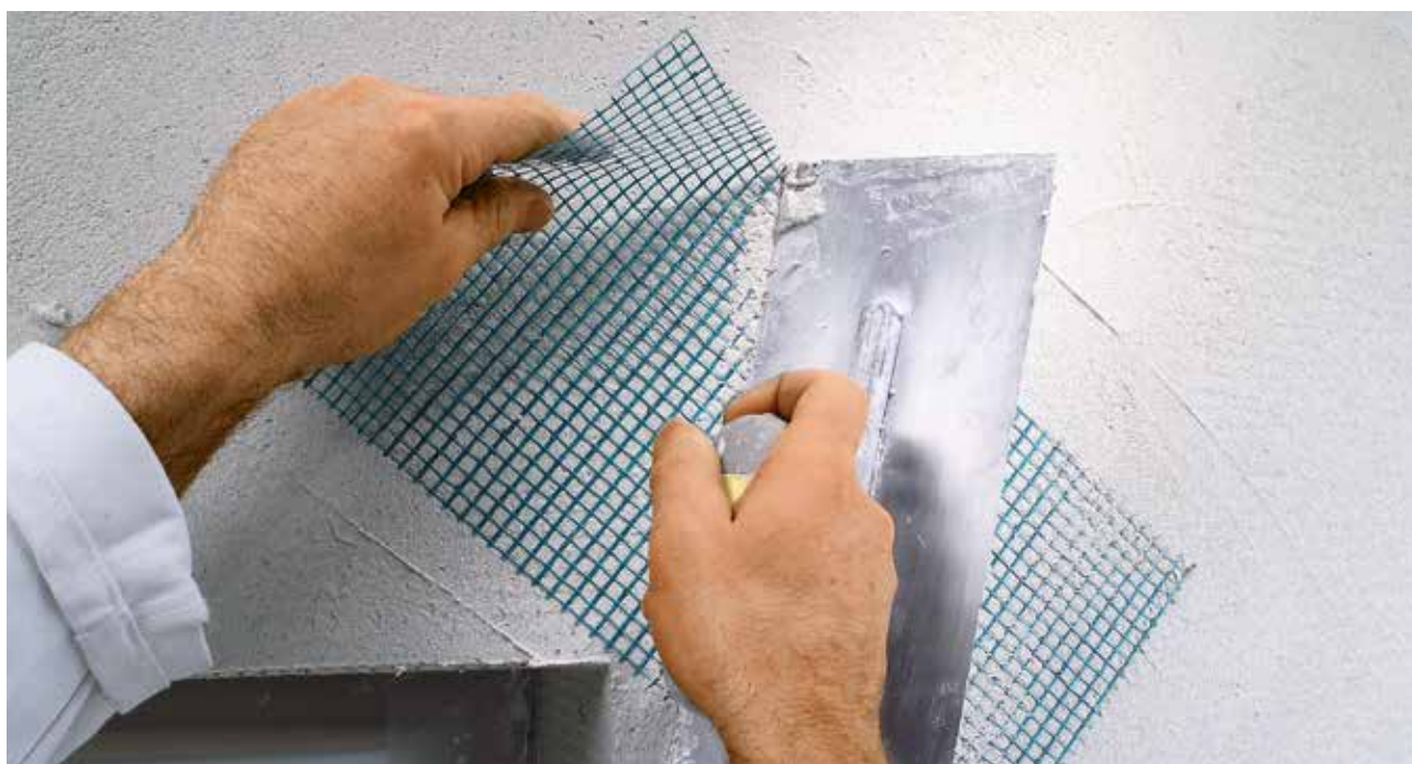
Afb. 19: Aanbrengen van diagonaalstroken.
