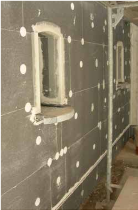
Afb. 15: Extra verankering van de isolatie.
