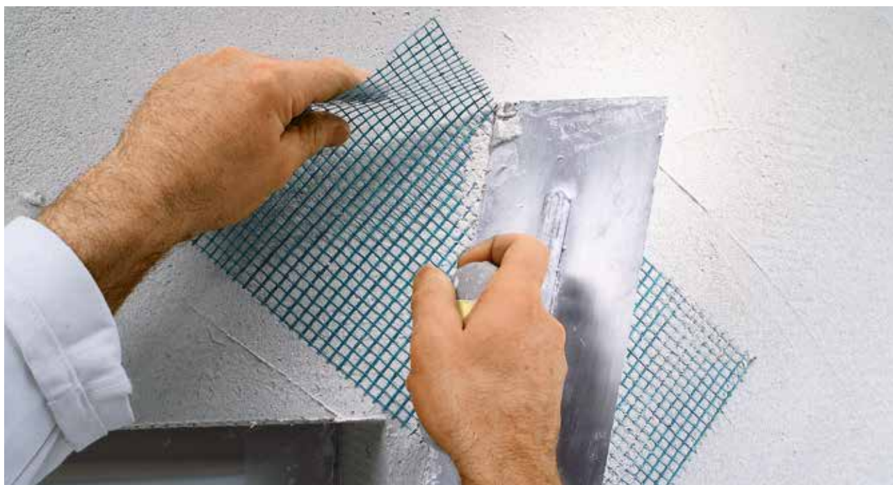
Afb. 19: Aanbrengen van diagonaalstroken
