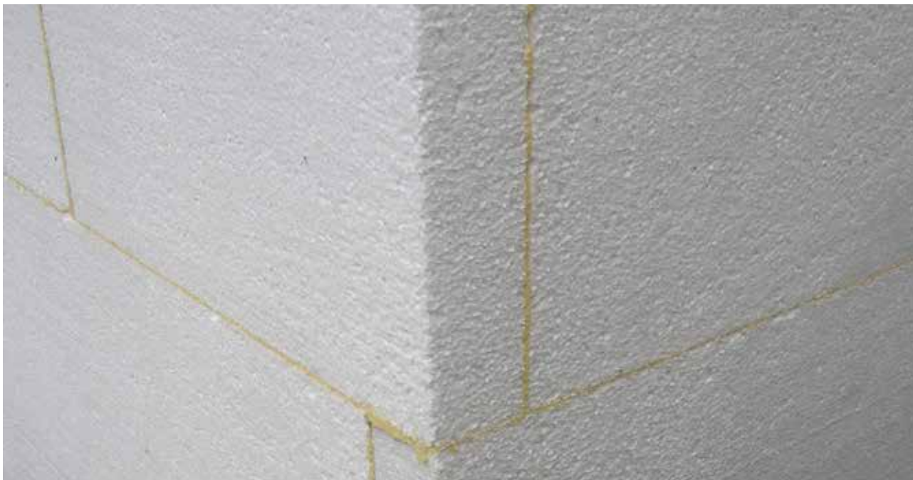
Afb. 14: Open naden opgevuld met PU-schuim
