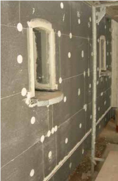
Afb. 15: Extra verankering van de isolatie
