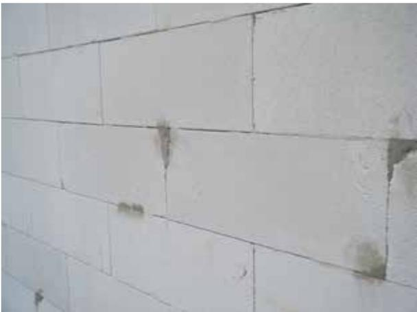
Fig. 6 : Béton cellulaire
