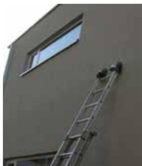
Fig. 34 : Échelle avec élément de répartition de charge
