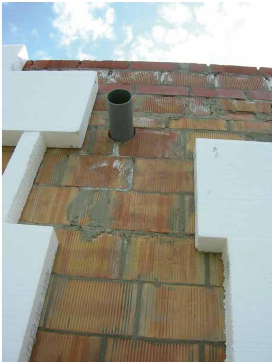
**Fig. 9 :** *Pas de protection contre l'humidité suite à l'absence de rive de toiture et d'évacuation de l'eau de pluie*
