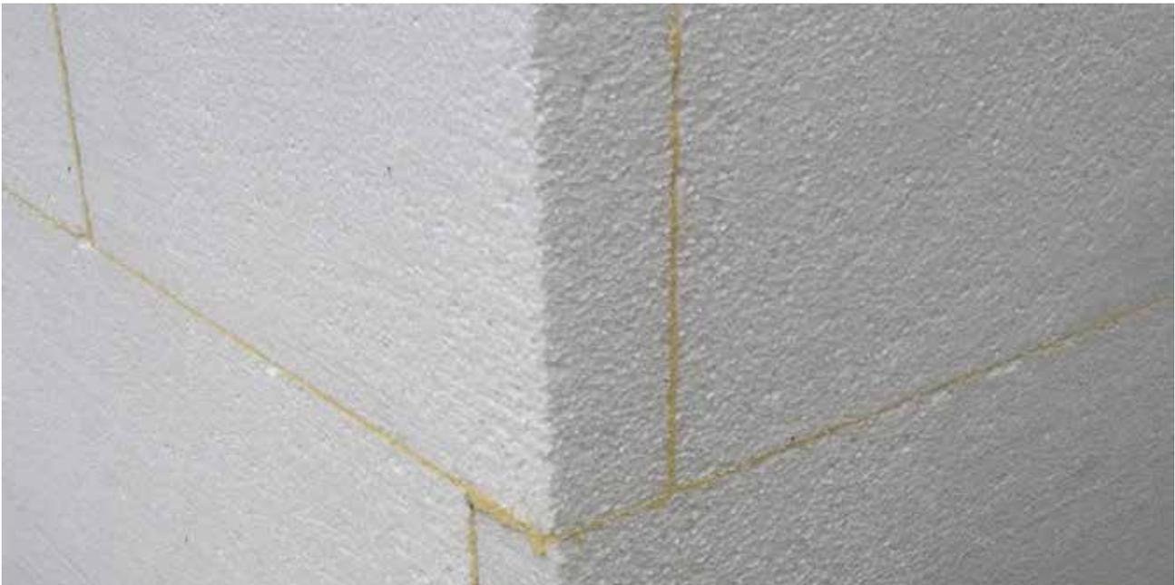
**Fig. 14 : Joints ouverts comblés de mousse PU**
