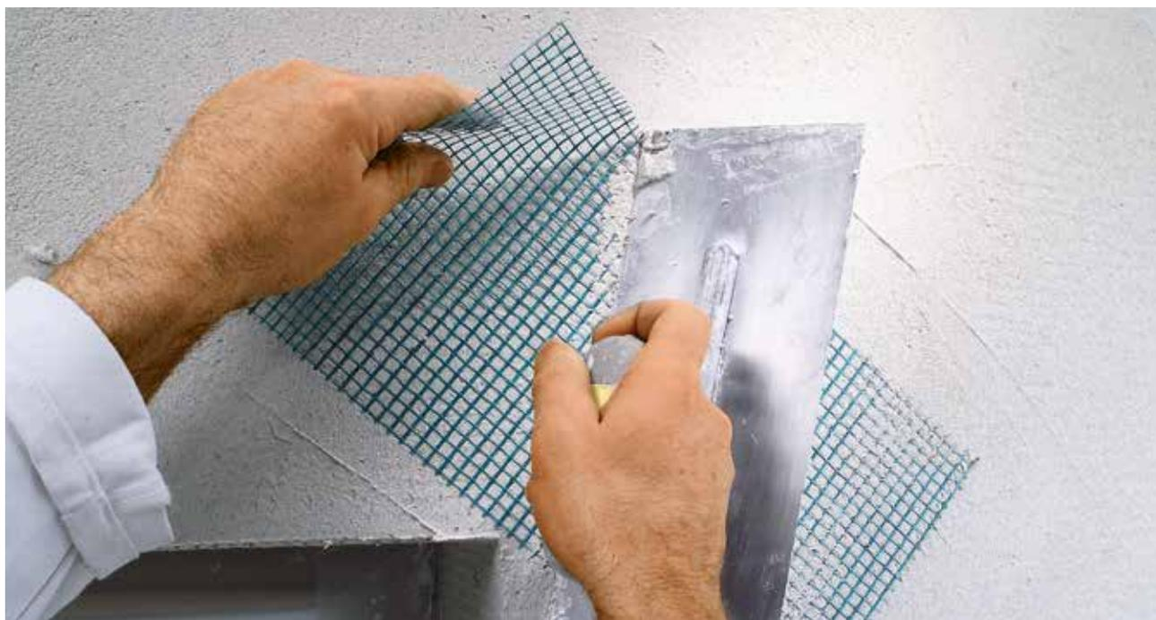
Fig. 19 : Application des bandes diagonales
