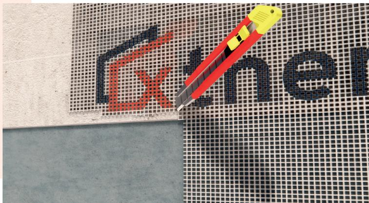
Contrôlez où se termine le treillis d'armature au niveau des angles. Le treillis doit être coupé après sa pose dans le mortier d'armature de manière à assurer une superposition complète avec le profilé d'angle.
