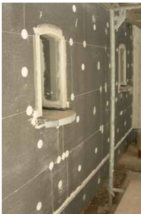
Fig. 15 : Ancrage supplémentaire de l'isolant
