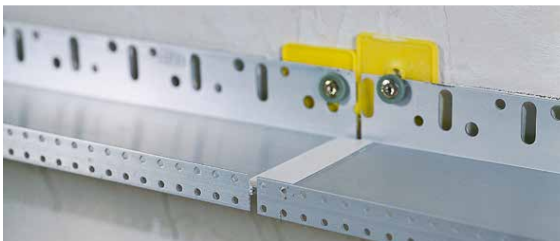
Fig. 11 : Placement du profilé de soubassement à l'aide de distanceurs et pièces de raccord
