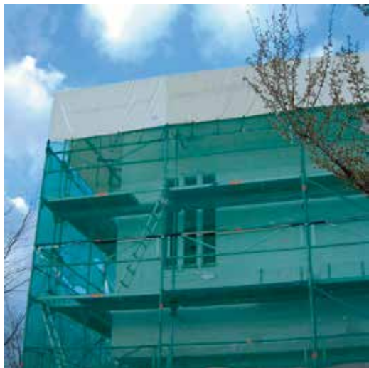
Fig. 8 : Echafaudage poutu de bâches
