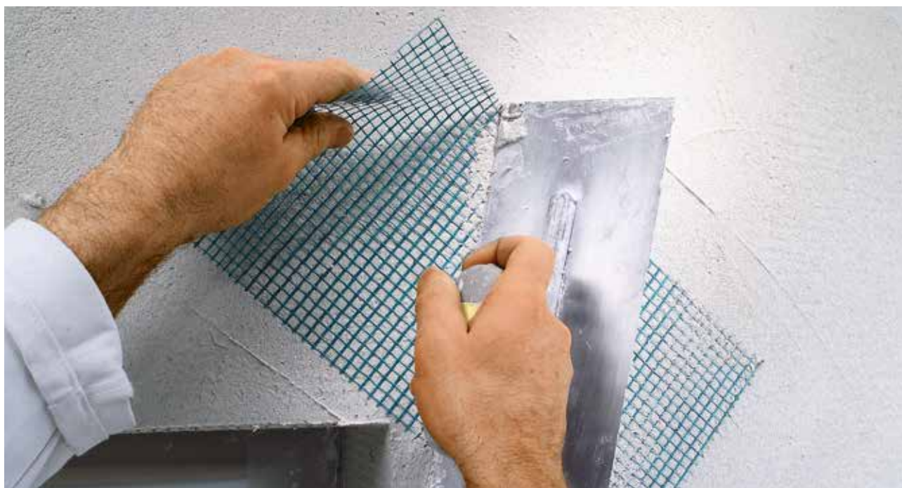
Fig. 19 : Application des bandes diagonales
