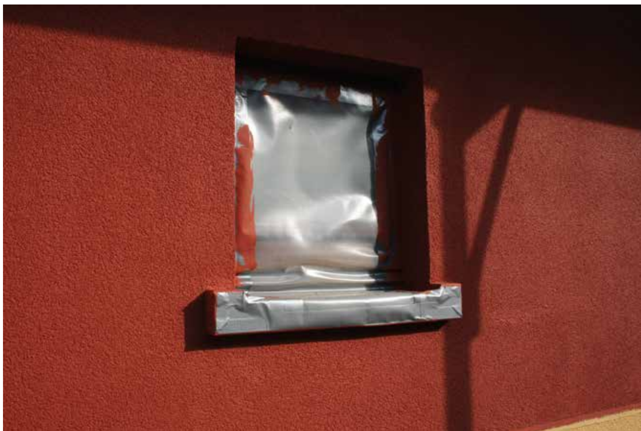
Fig. 44 : détails application de peinture
