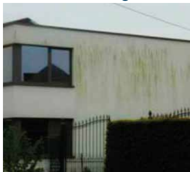
Fig. 35 & 36 : algues et moisissures avant et après traitement (produit désinfectant)
