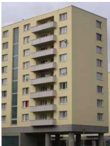
Fig. 27 : Ancrage supplémentaire suite à de plus fortes charges au vent
