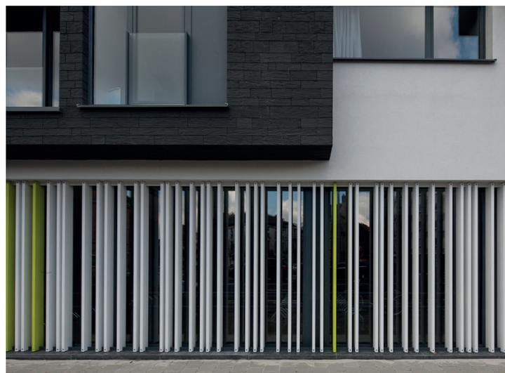
Les plaquettes souples permettent d'imiter très fidèlement les briques existantes. Parallèlement, de nombreux projets ont déjà été réalisés avec des plaquettes fabriquées sur mesure.
